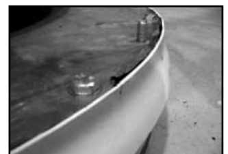
Planettätning – detaljbild
